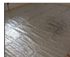
Rozložení rohože na Izola™ 6 mm izolaci.
